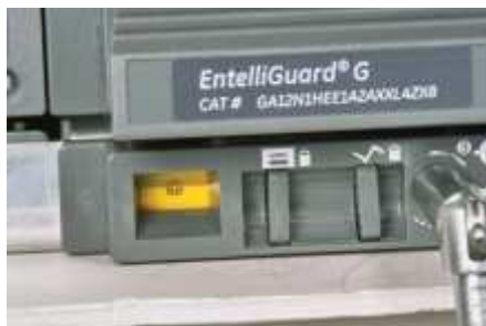
Racking drive in TEST position Einfahrstellungsanzeige in TEST-Stellung Naped wsuwania w polozeniu PROBA
