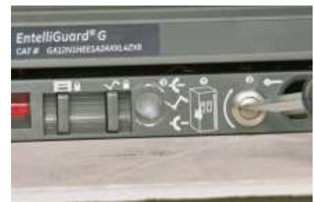
Racking Handle Shutter drive location Verstellschraube für Schutzkappenantrieb Sruba przesuwajaca przeslone otworu korby
