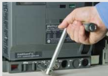
Fig. 1.12: Circuit Breaker in Maintenance Position Abb. 1.12: Leistungsschalter in Wartungsstellung Fot. 1.12: Wyłącznik w położeniu "Konservacja" (Wysunięty)
