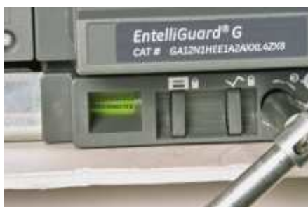
Racking drive in DISCONNECTED position Einfahrstellungsanzeige in GETRENNT-Stellung Naped wsuwania w polozeniu ODL. CZONY
