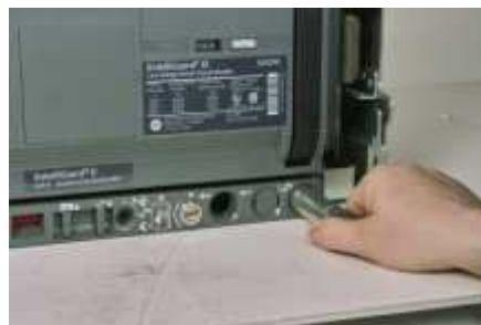
Racking Handle Storage Location Einfahrkurbel Lagerungsort Schowek korby wsuwania
