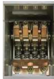
Fig 5.2: contact gap / Abb. 5.2 Kontaktabstand Fot. 5.2: Szczelina między stykami
