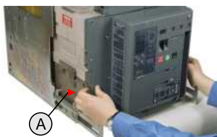
Fig. 1.3: Hand Grip Location Abb. 1.3: Lage Handgriffe Fot. 1.3: Urmiescowienie uchwytów ręcznych
