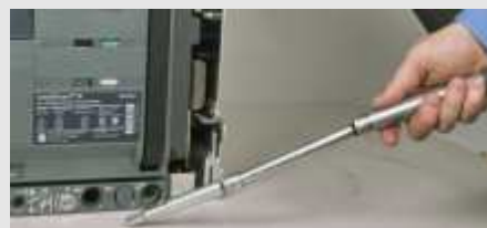
Fig. 1.10: Racking Handle use Abb. 1.10: Einfahrkurbel Verwendung Fot. 1.10: Rozłożenie korbę
