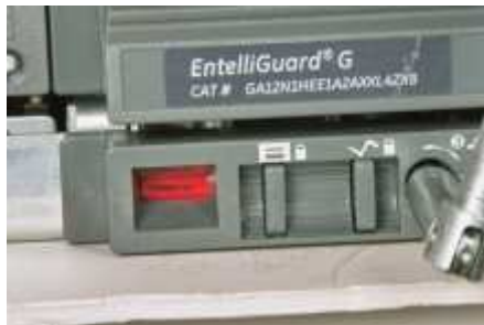
Racking drive in CONNECTED position Einfahrstellungsanzeige in BETRIEBs-Stellung Naped wsuwania w polozeniu PRACA
