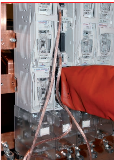
uziemiaenie rozłącznika
